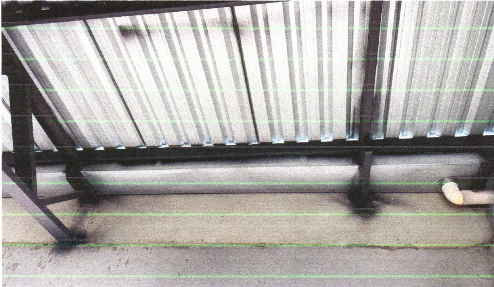
FOTO 97: INSTALAÇÃO DE TELHA METÁLICA E CALHA PLUVIAL
