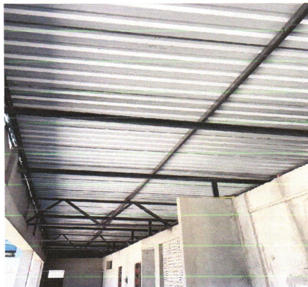
FOTO 110: INSTALAÇÃO TELHA METÁLICA
