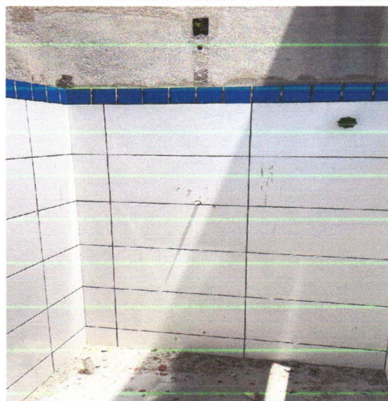
FOTO 104: ASSENTAMENTO DE REVESTIMENTO CERÂMICO
